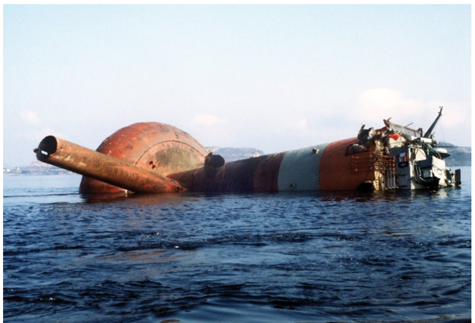
Abb. 2: Details der aufgrund von Ermüdung gekenterten Bohrplattform (Nordsee, 1980)
